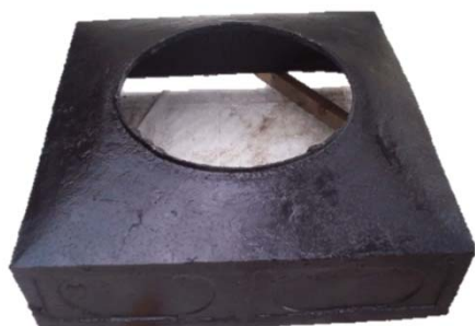
露盤色直し及び、補強
