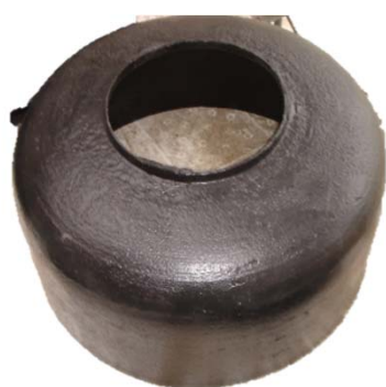
伏鉢色直し及び、内側補強
