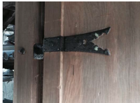
現場にて錆落とし及び、塗直し
